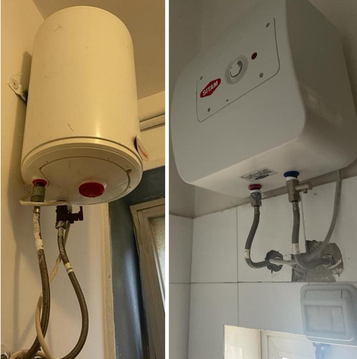
Fig 7.3.1: boiler presenti all'interno dell'edificio
