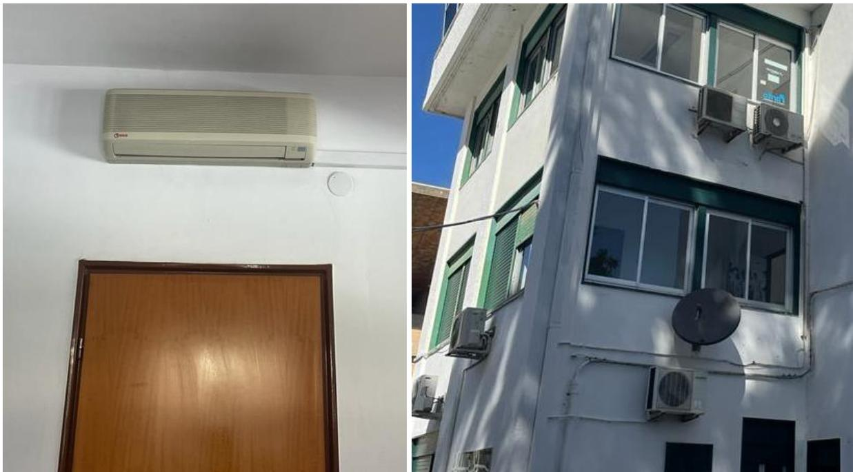
Fig 7.2.1: esempio di unità esterne e interna climatizzatori
